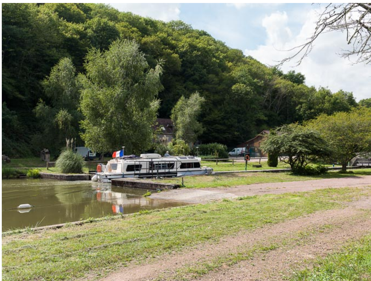
Vue du site d'écluse.
