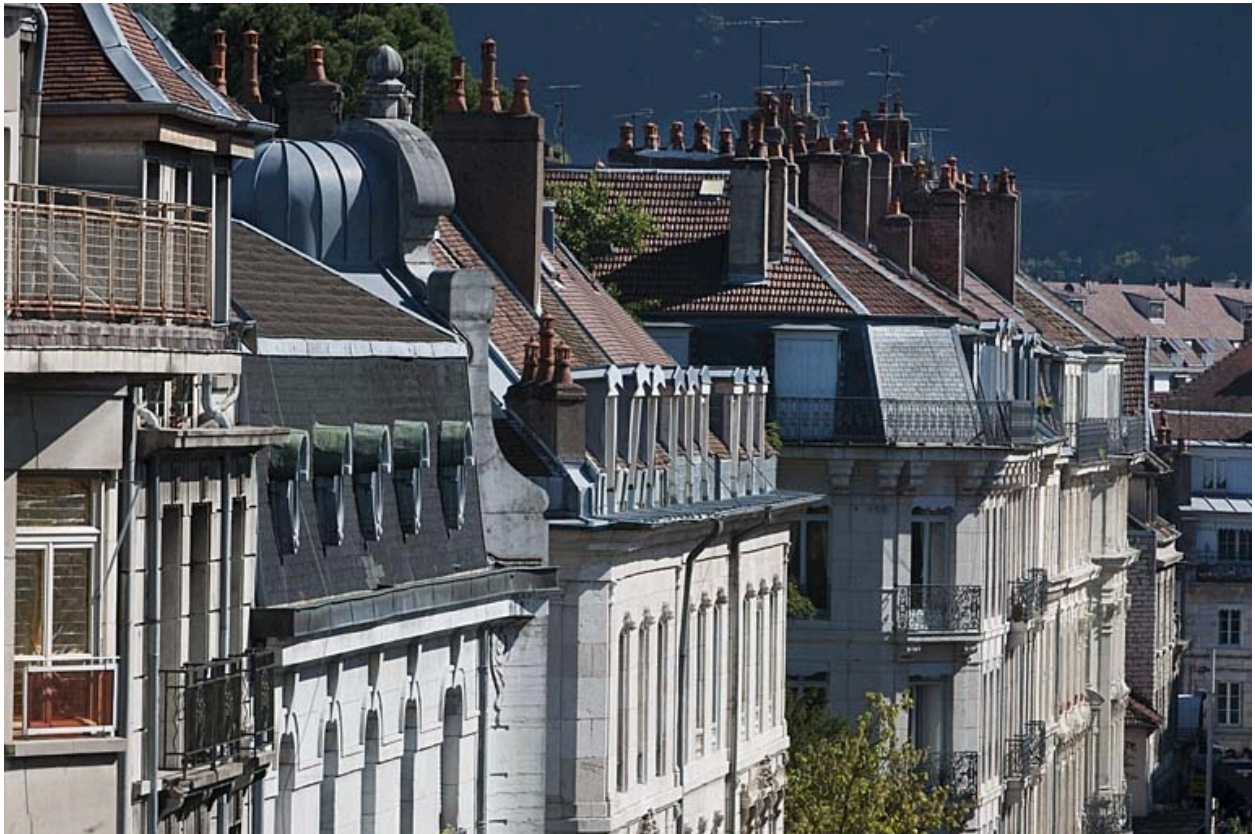
Vue des toits d'une partie de la rue Proudhon depuis le haut d'un immeuble.
