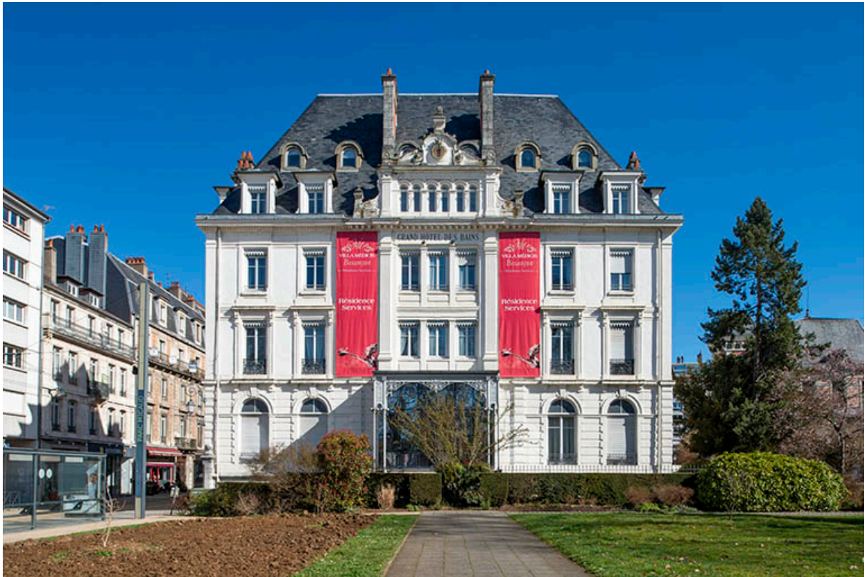
Façade sur l'avenue Édouard Droz.
