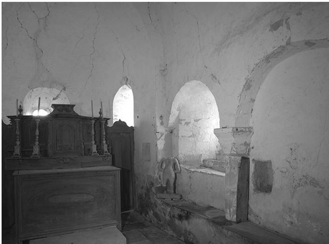
Mur droit du choeur.
