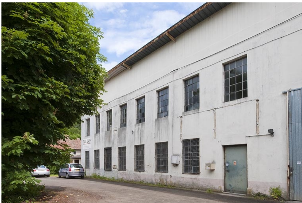
Façade nord de l'atelier de fabrication.
