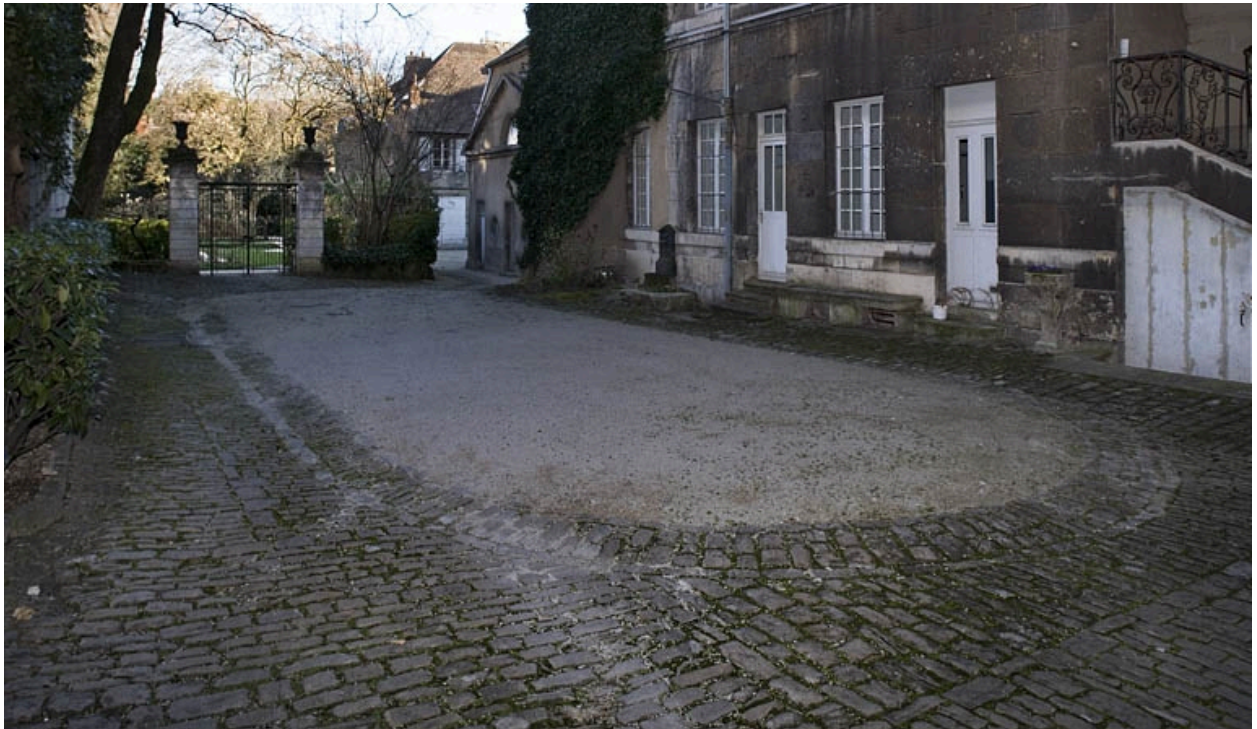
Vue d'ensemble du pavage de la cour.
