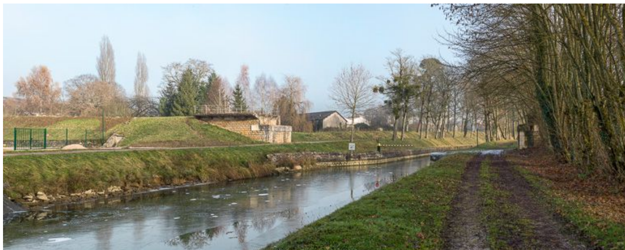
Vue d'aval des culées.
