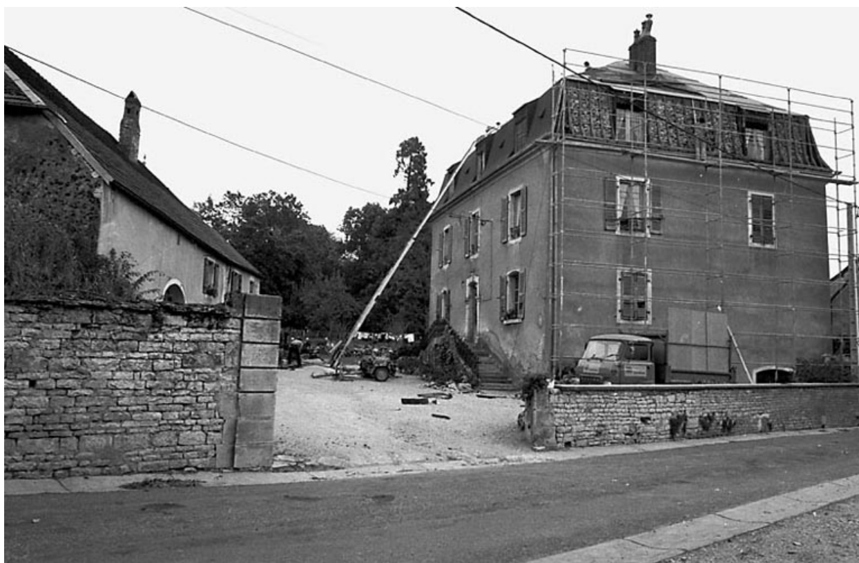
Maison située rue de l'Eglise.
