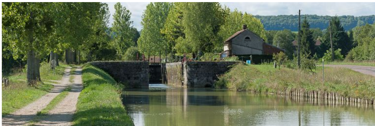
Vue du site d'écluse depuis l'aval.
