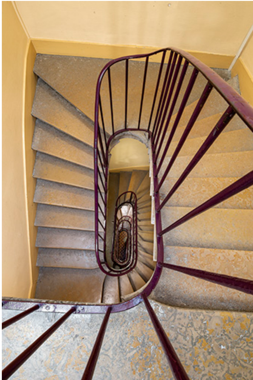
Bâtiment d'entrée : escalier de l'administration.
