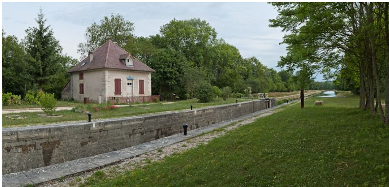
Vue d'ensemble du site d'écluse.
