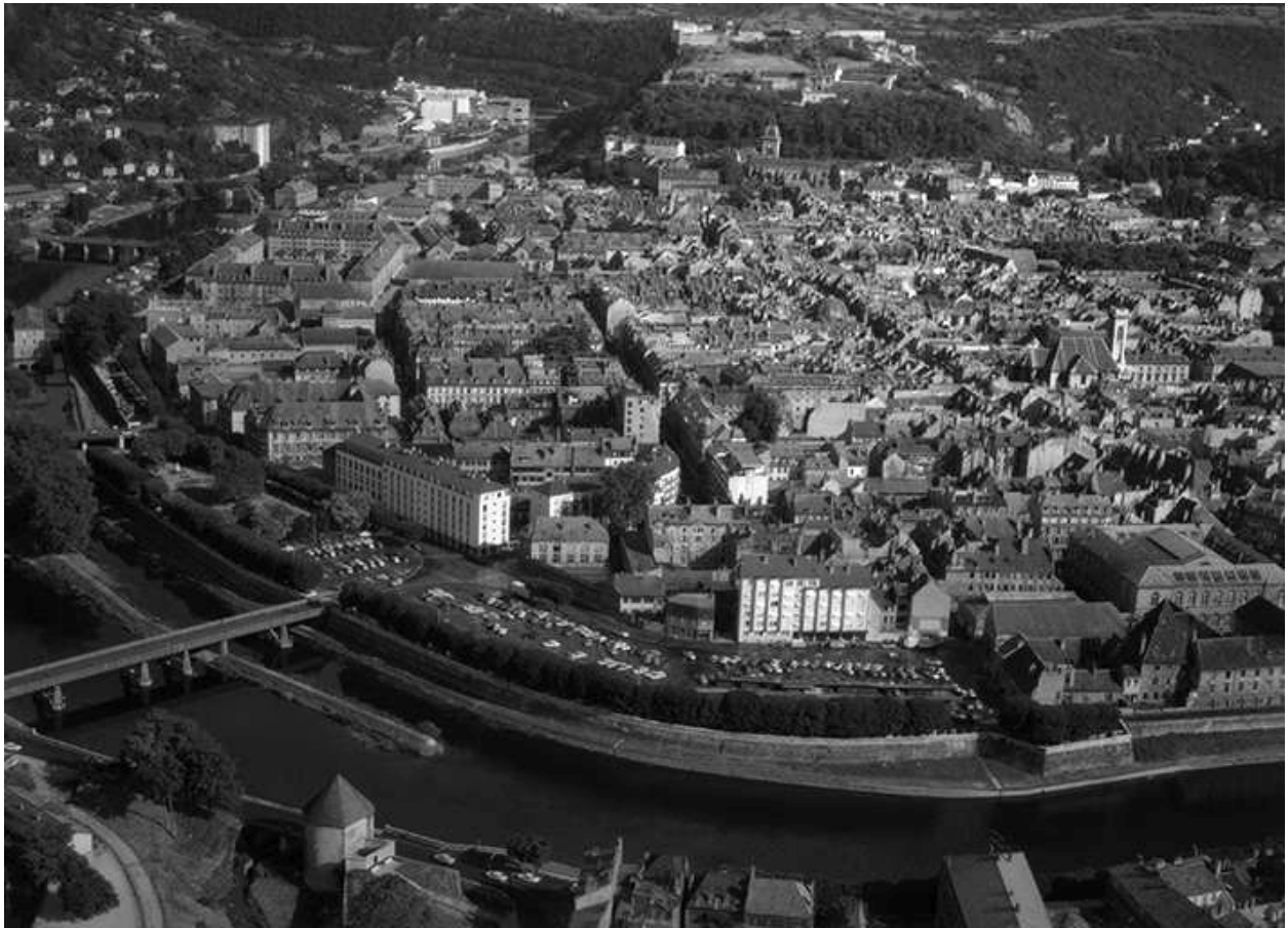
Vue aérienne du centre-ville depuis le quartier Battant en 1964.
