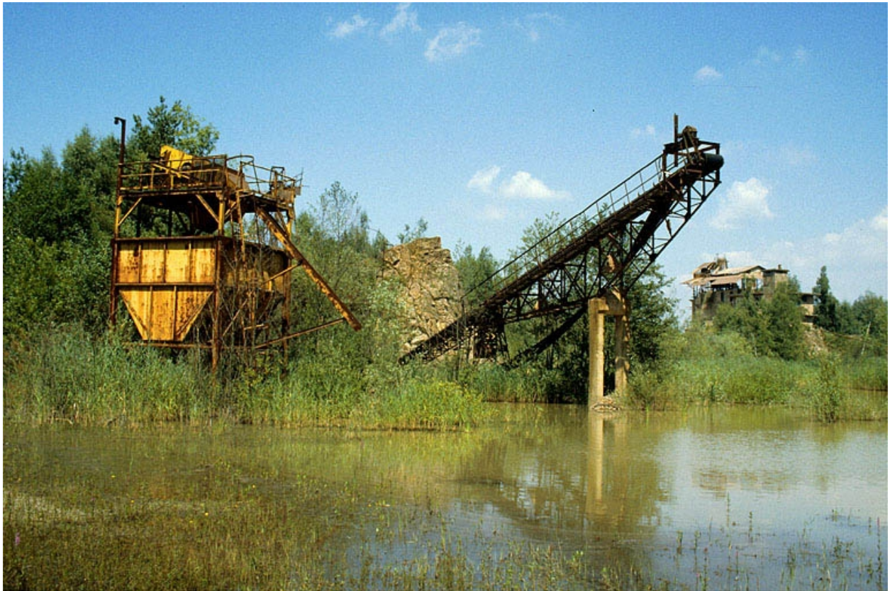
Anciennes installations vues de l'ouest, en 1988.
