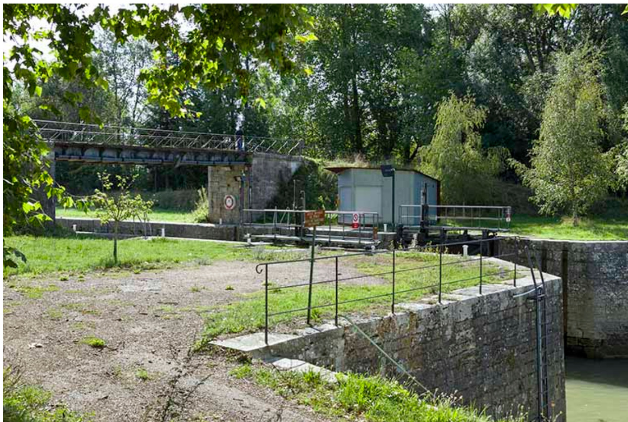
Le poste de commande de l'écluse.
