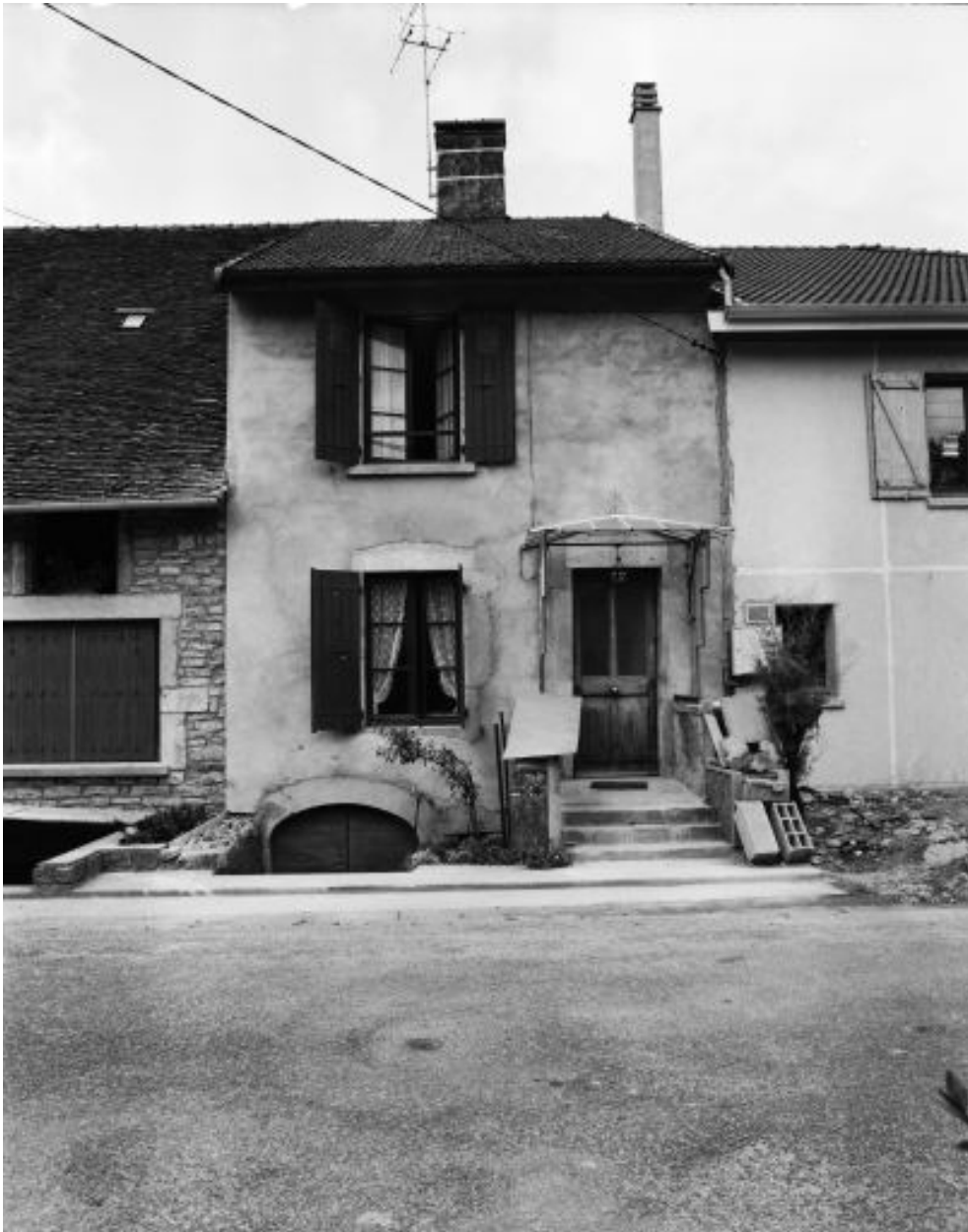
Ferme située rue Roche : façade antérieure.
