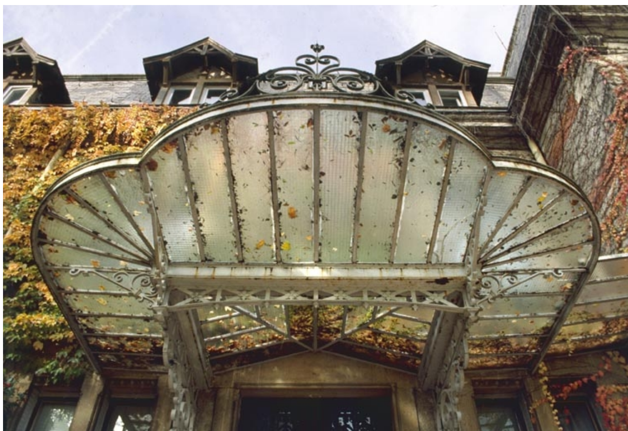
Marquise de la façade sud.
