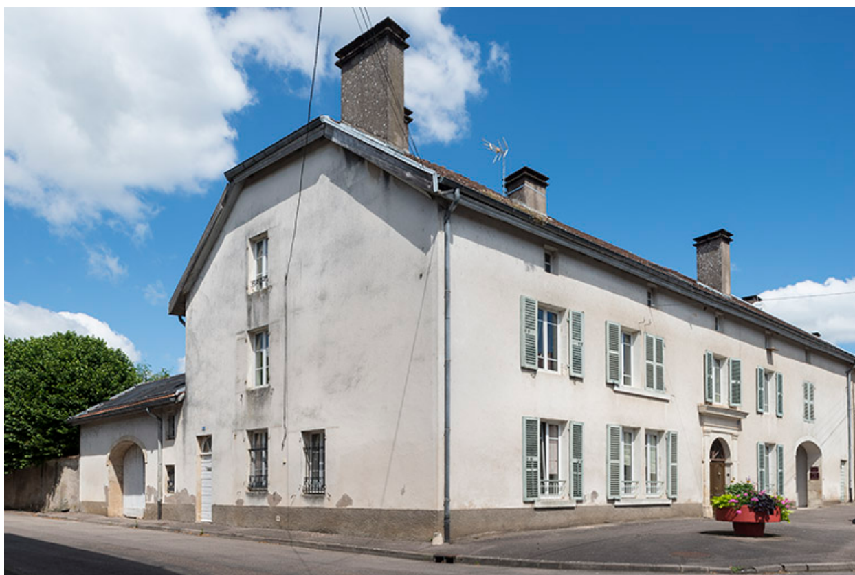
Le mur pignon sud.
