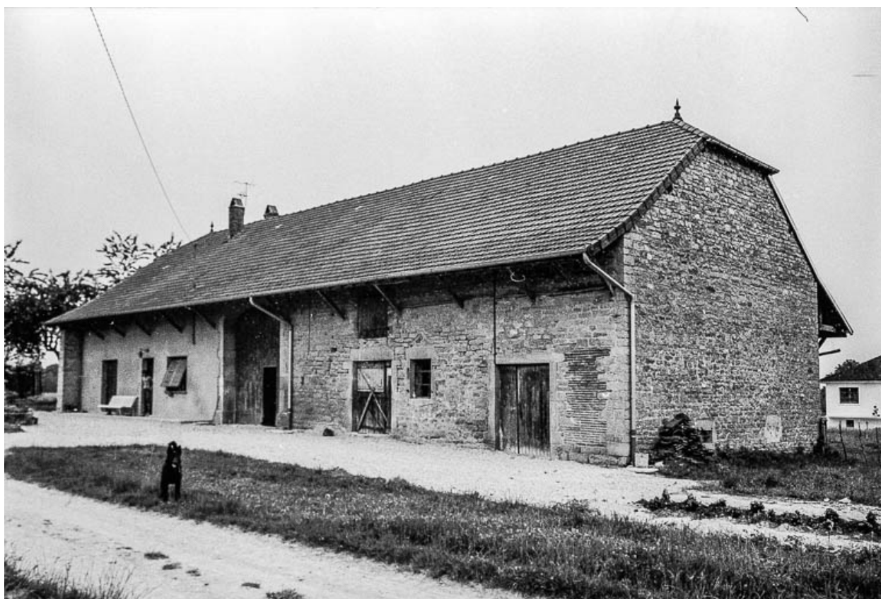
Ferme cadastrée 1969 AI 46 : façade antérieure.
