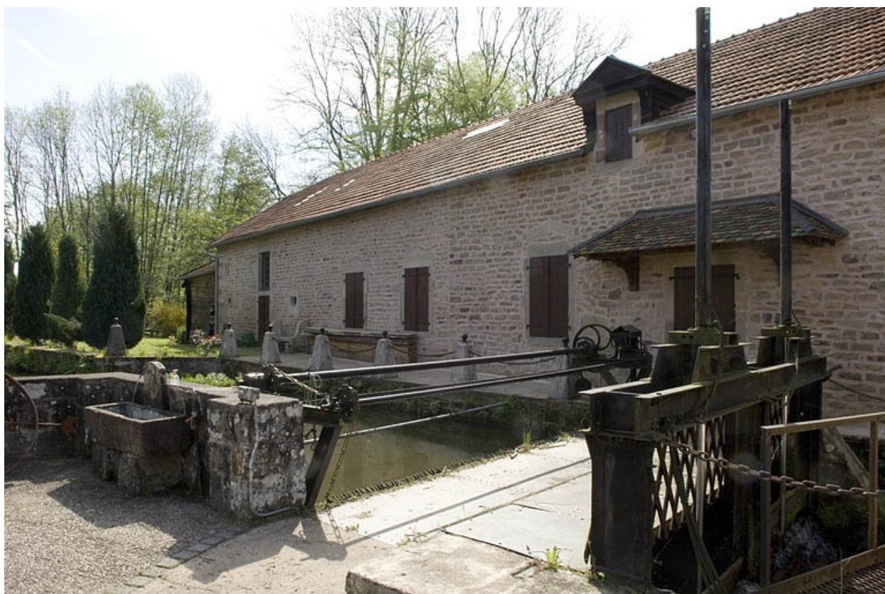
Logement (rive gauche) depuis l'est.
