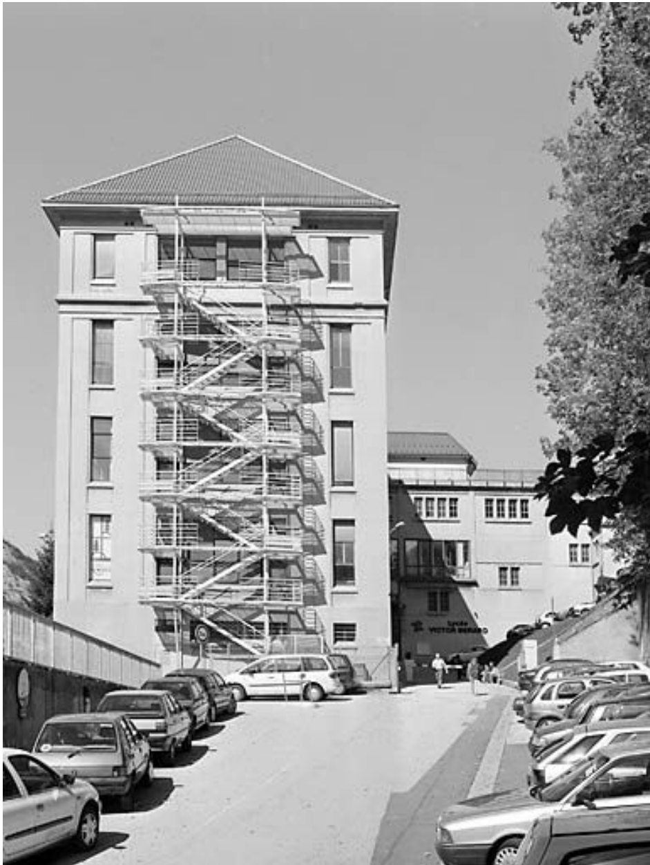
Bâtiment B : façade latérale droite.
