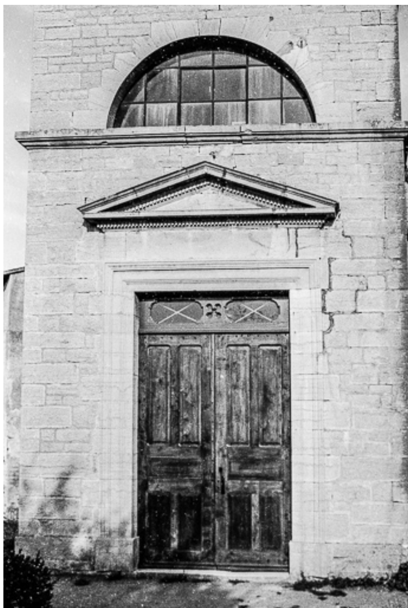
Façade antérieure : la porte.
