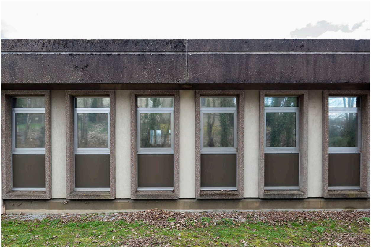
Ancien laboratoire de métrologie : fenêtres.
