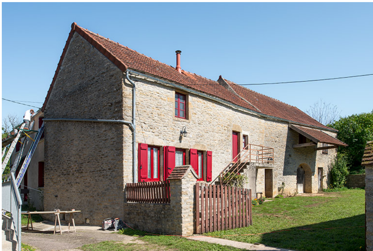
Le corps principal de la ferme vu depuis l'ouest.
