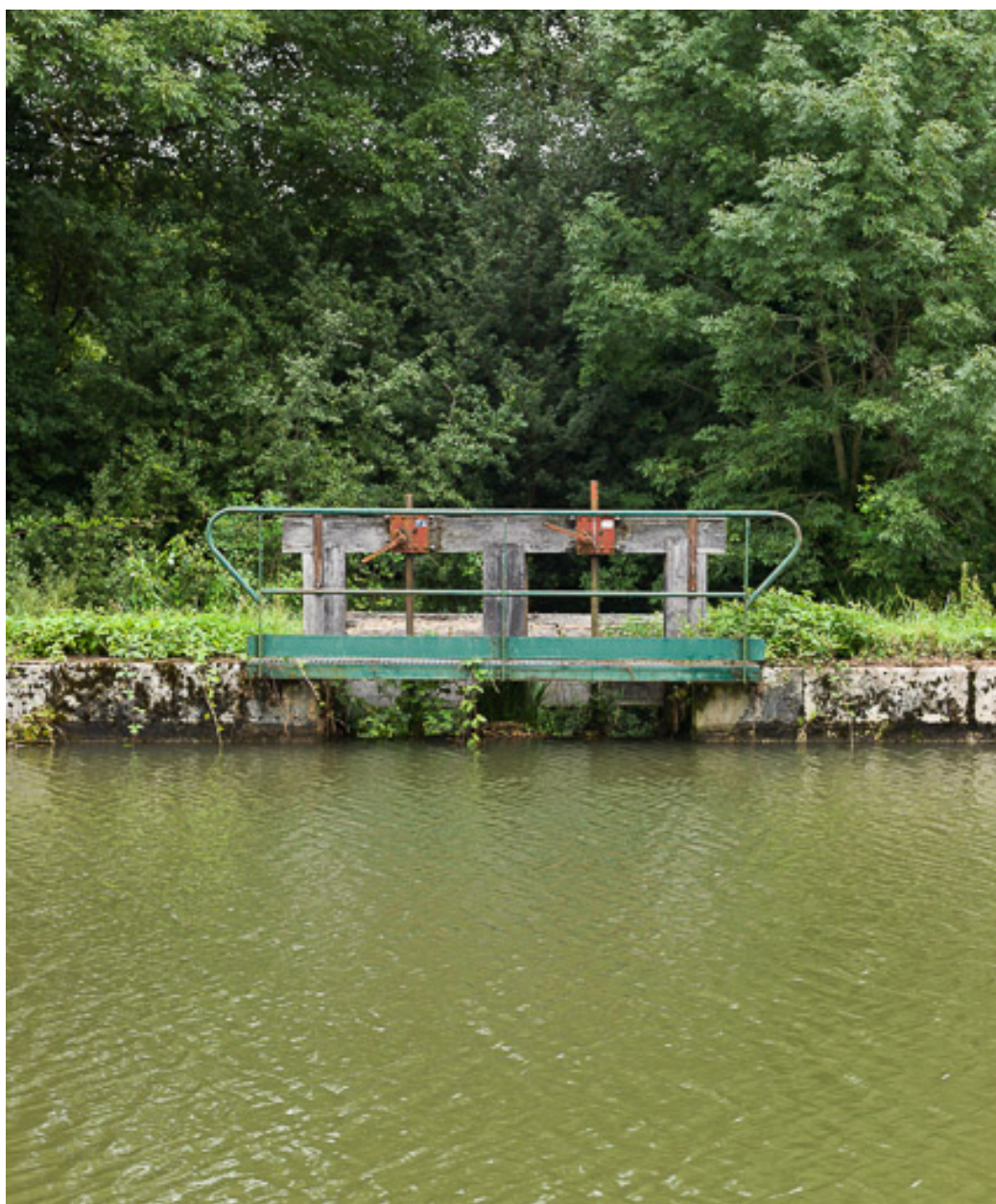
Vue du déversoir de fond.
