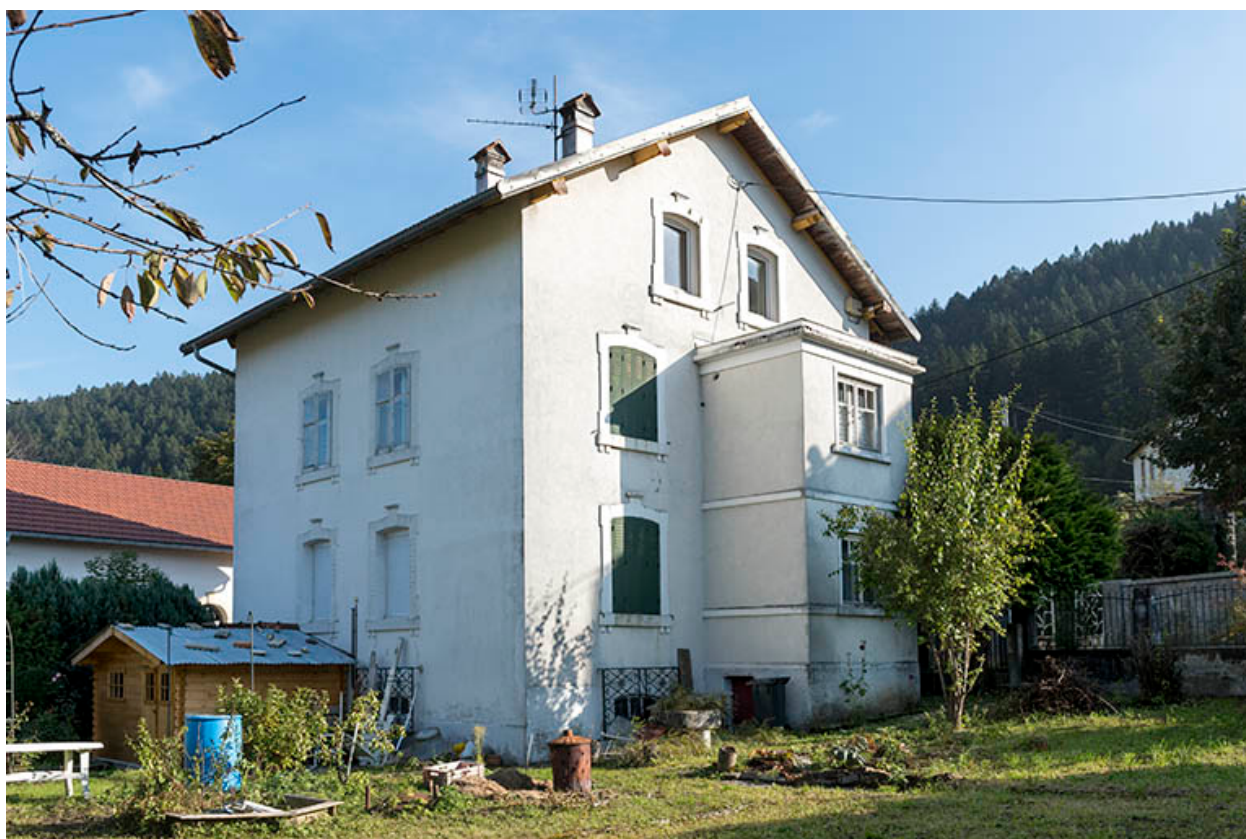
Façades postérieure et latérale gauche.
