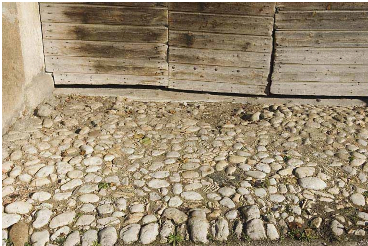
Façade antérieure : pavage devant la grange.
