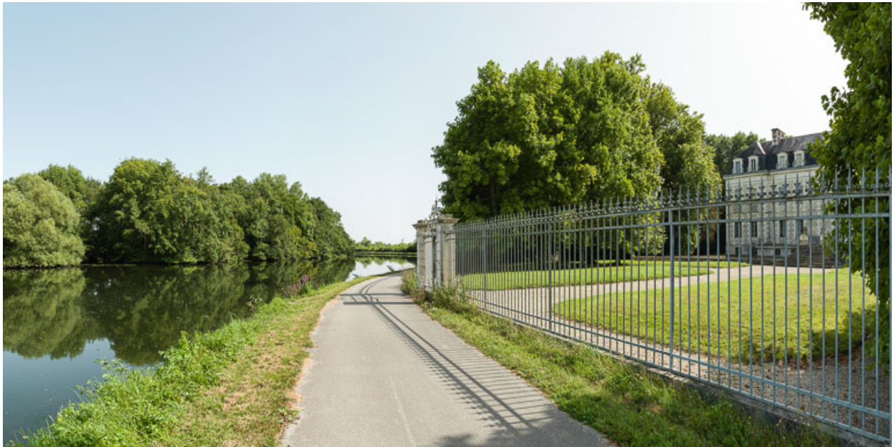
Vue du château sur la rive gauche du canal.
