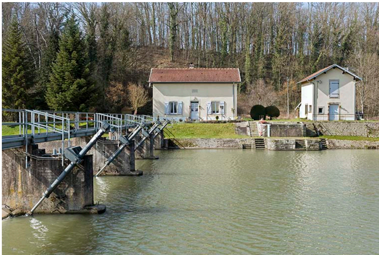
Le barrage et la maison du barragiste.
