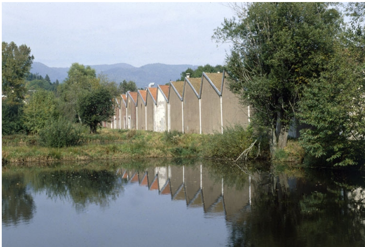
Etang et murs-pignons de l'atelier de filature.
