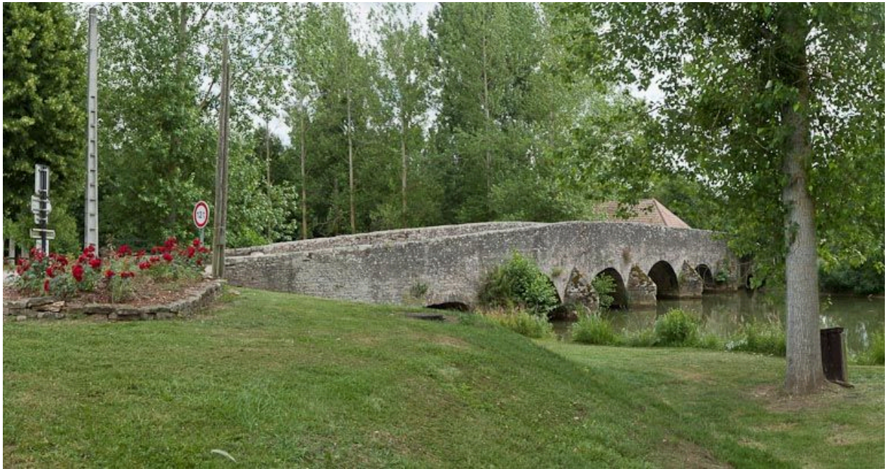
Vue du pont ancien sur l'Ouche prolongeant le pont sur l'écluse 36 du versant Saône.
