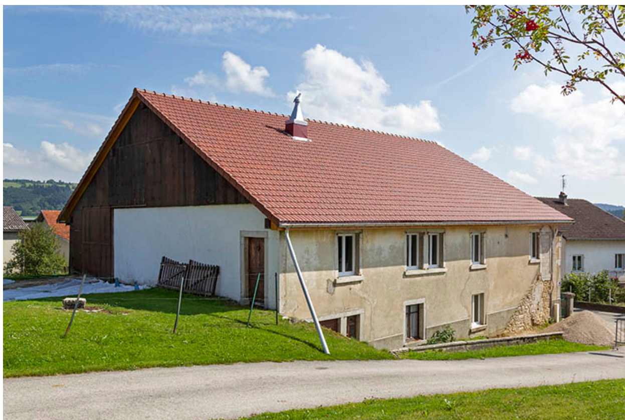
Façades postérieure et latérale gauche.
