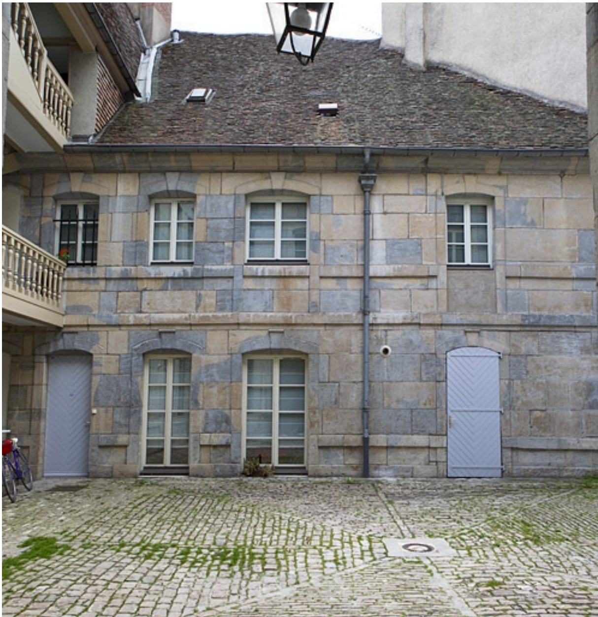
Vue d'ensemble de la façade antérieure du logis secondaire en fond de cour.
