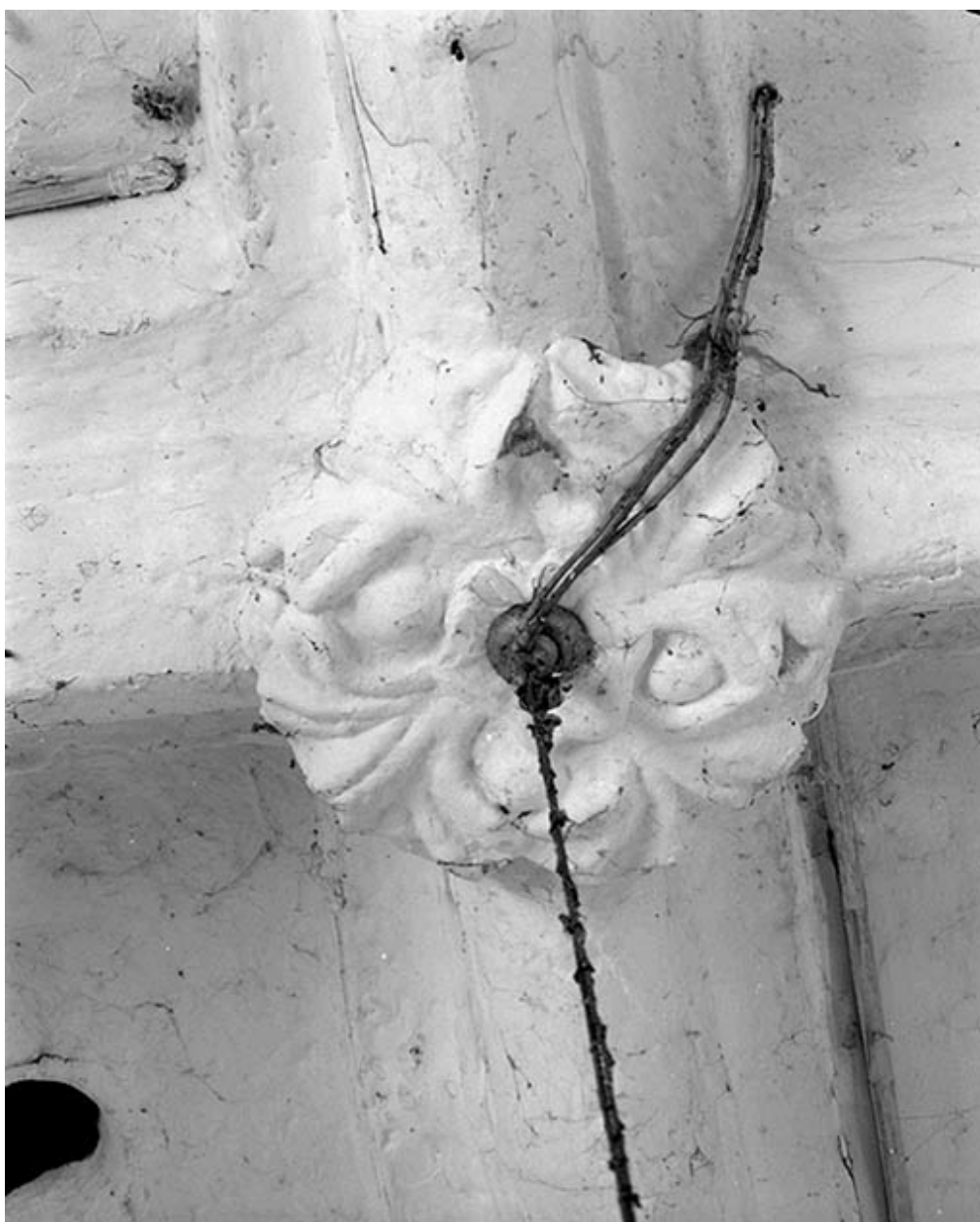
Détail : clef de voûte, dans le chœur.
