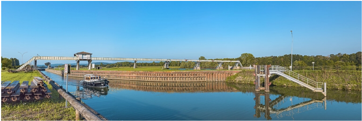
Le site d'écluse vu d'amont.
