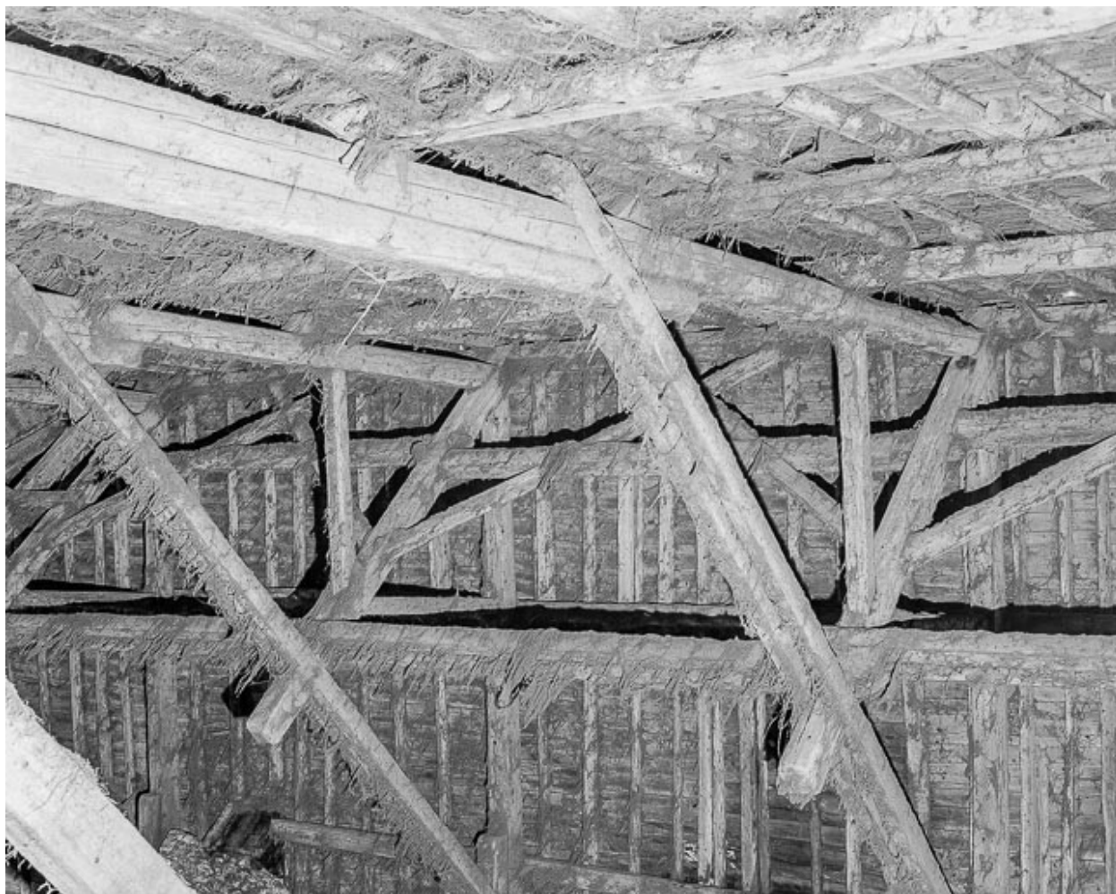
Charpente, partie supérieure.
