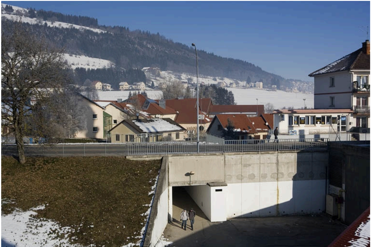
Site ancien : tunnel.
