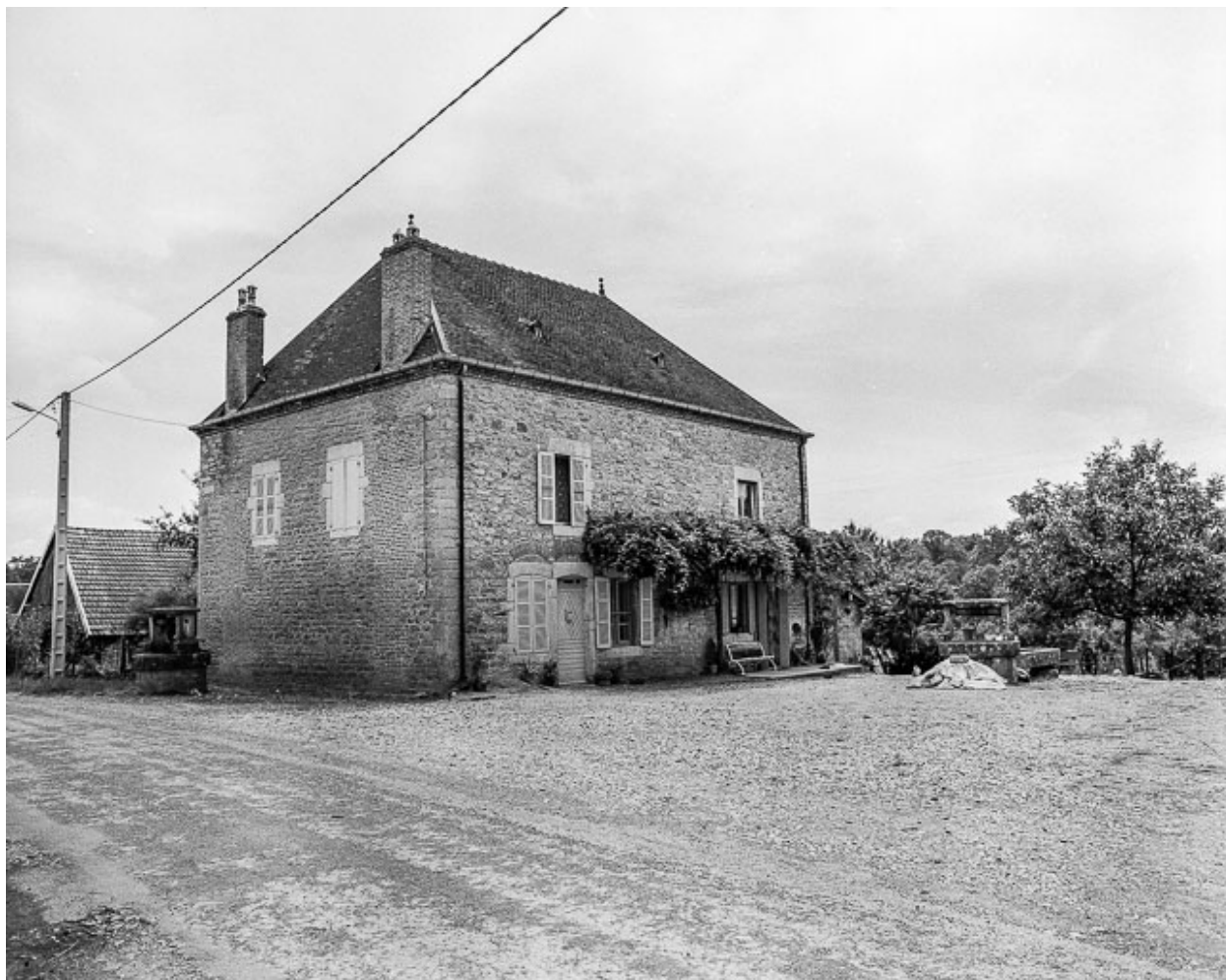
Le bâtiment d'habitation, façade antérieure.
