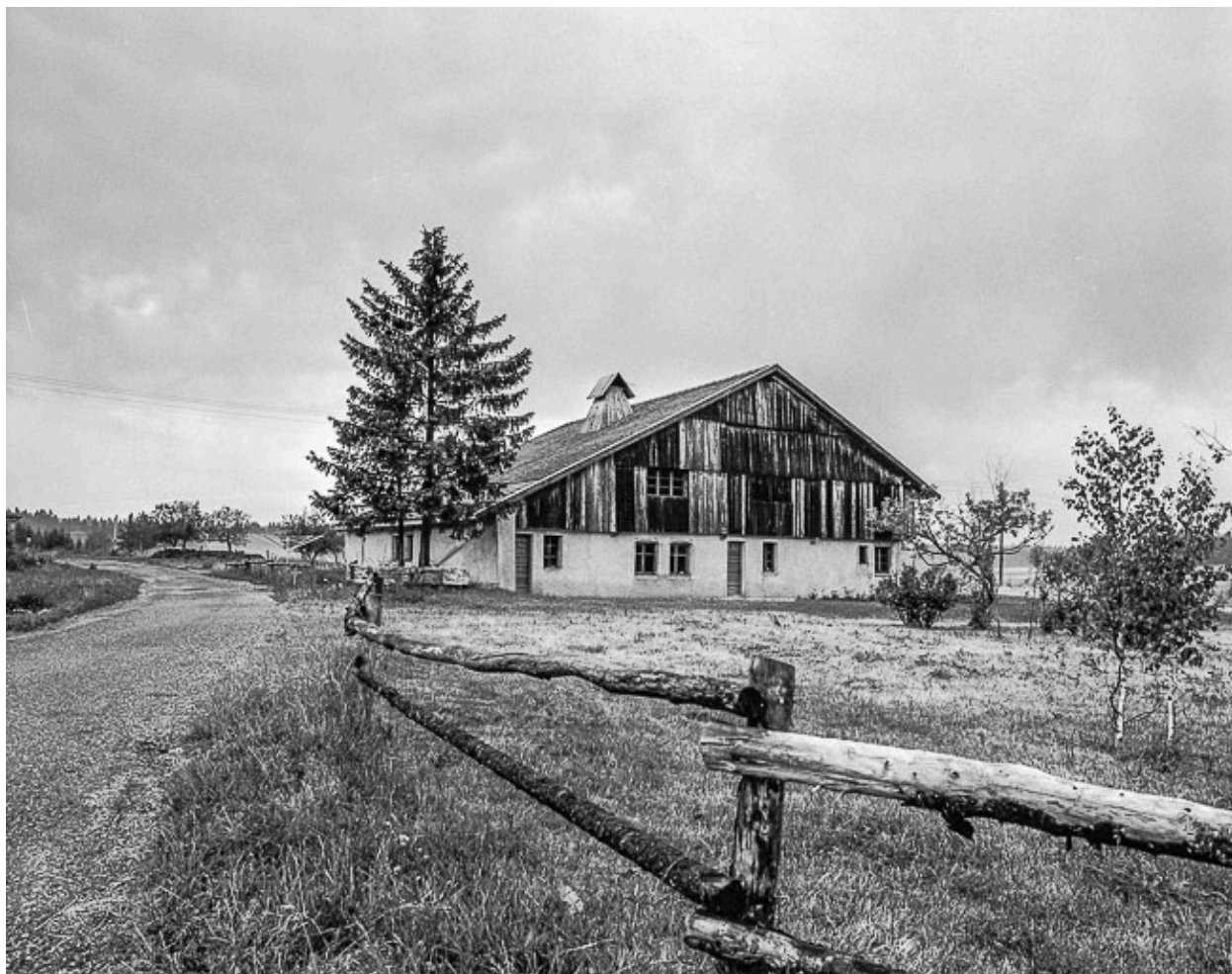
Ferme située au lieu-dit Combe d'Abondance, cadastrée B2 247 : façades postérieure et latérale droite.
