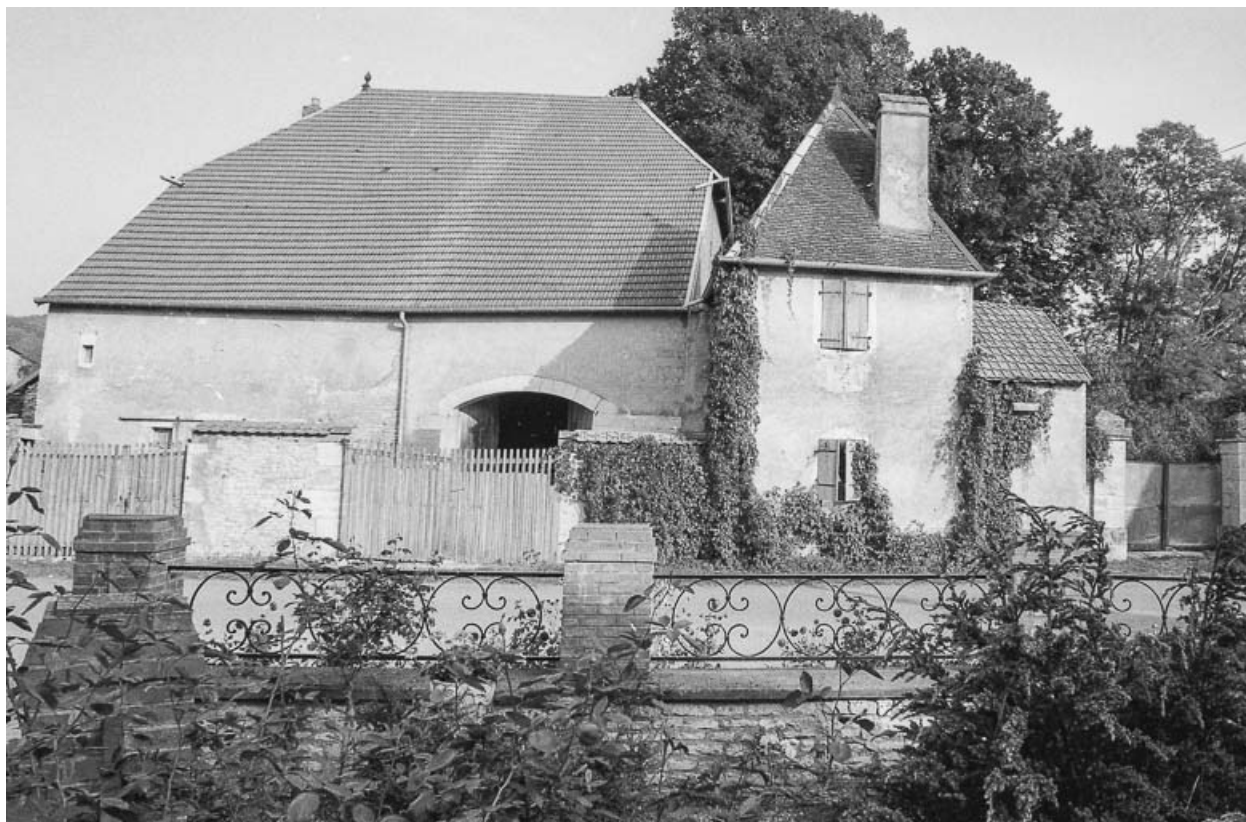
Maison située rue Basse.
