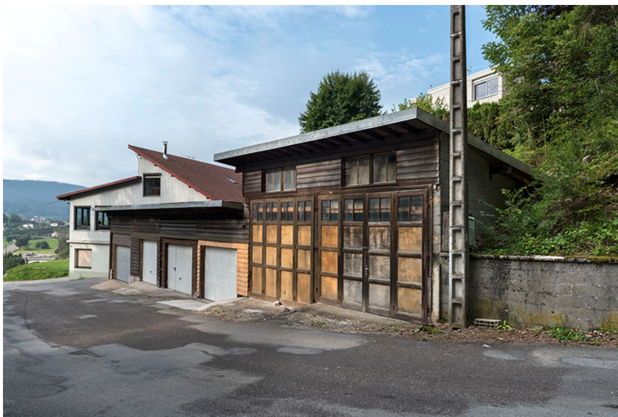
Garages, depuis le nord-est.
