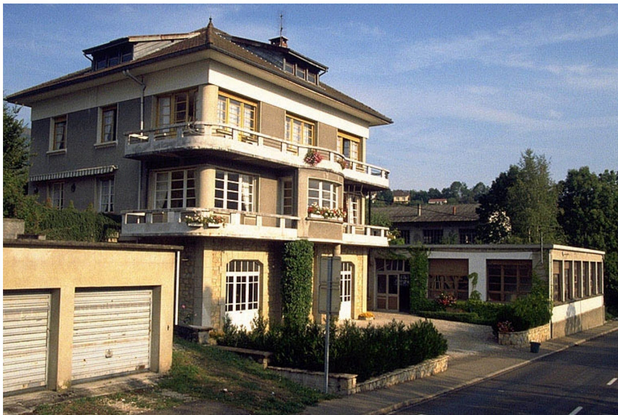
Logement patronal et atelier de fabrication (tournerie).
