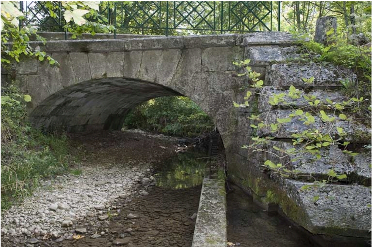
Pont sur la Jougne (n° 3), vu depuis l'amont.
