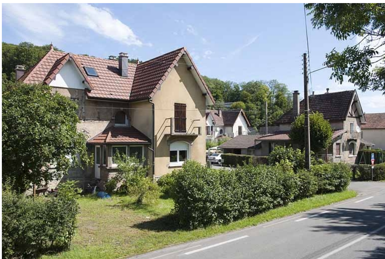
Maisons à deux logements de contremaître.
