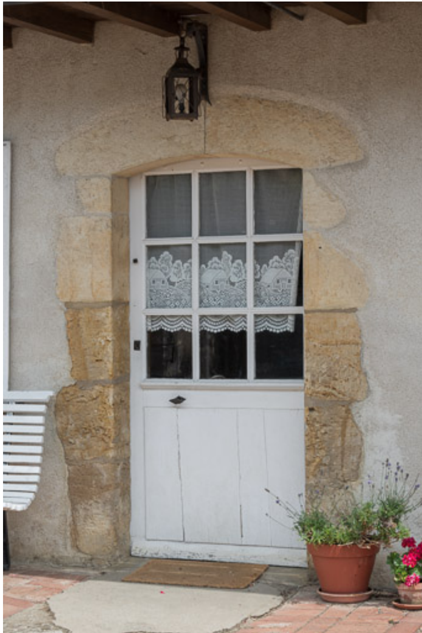
Porte de la maison couverte d'un arc segmentaire (XVIIIe siècle)
