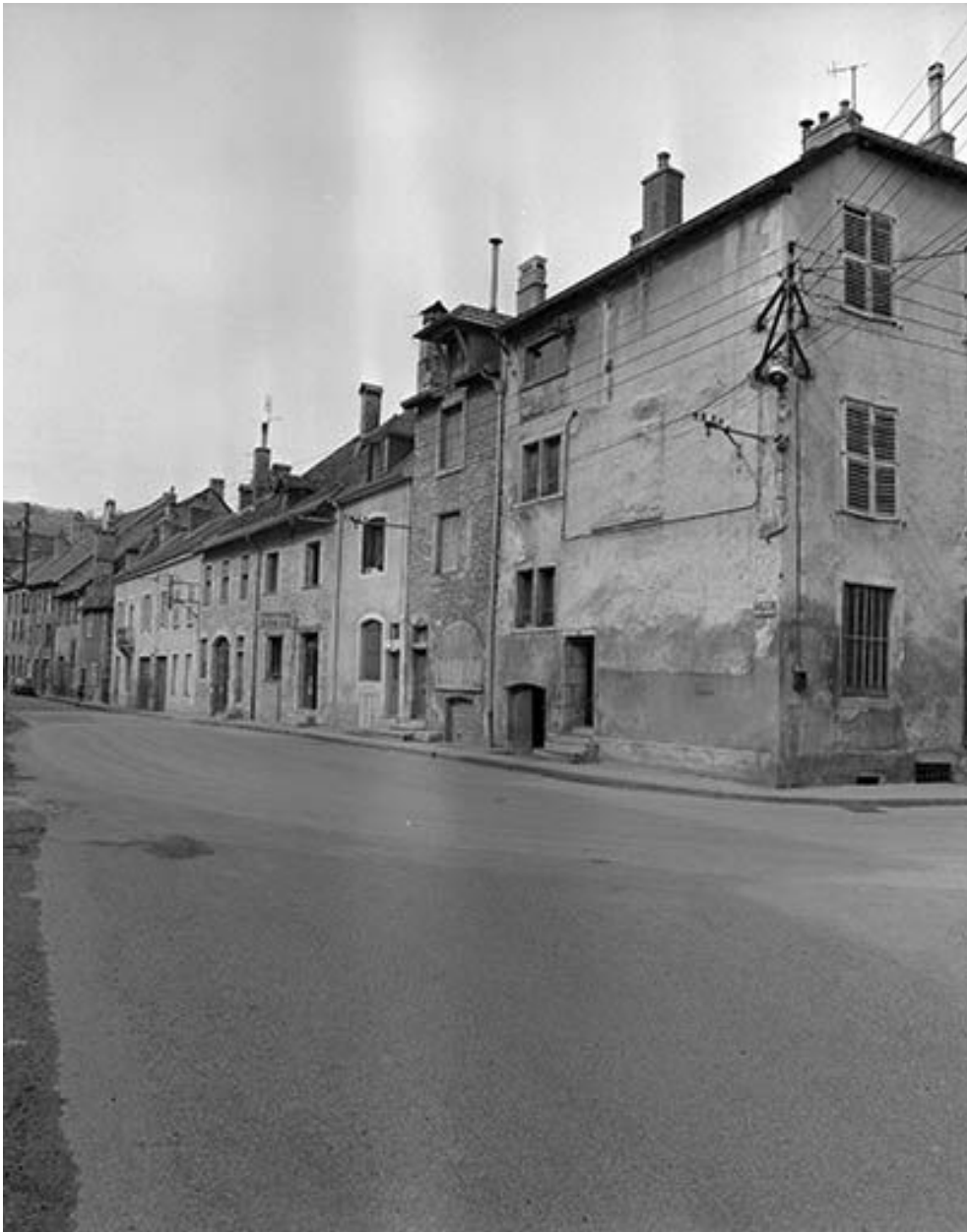
Maisons côté pair de la rue Saint-Laurent : vue générale.
