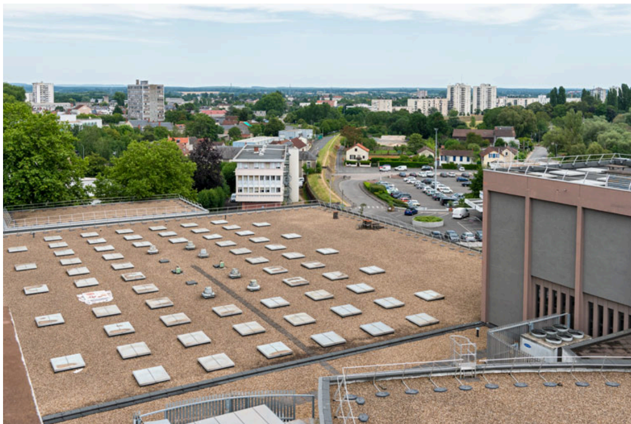
Maison des sports : vue plongeante sur le toit, depuis la bourse du travail.
