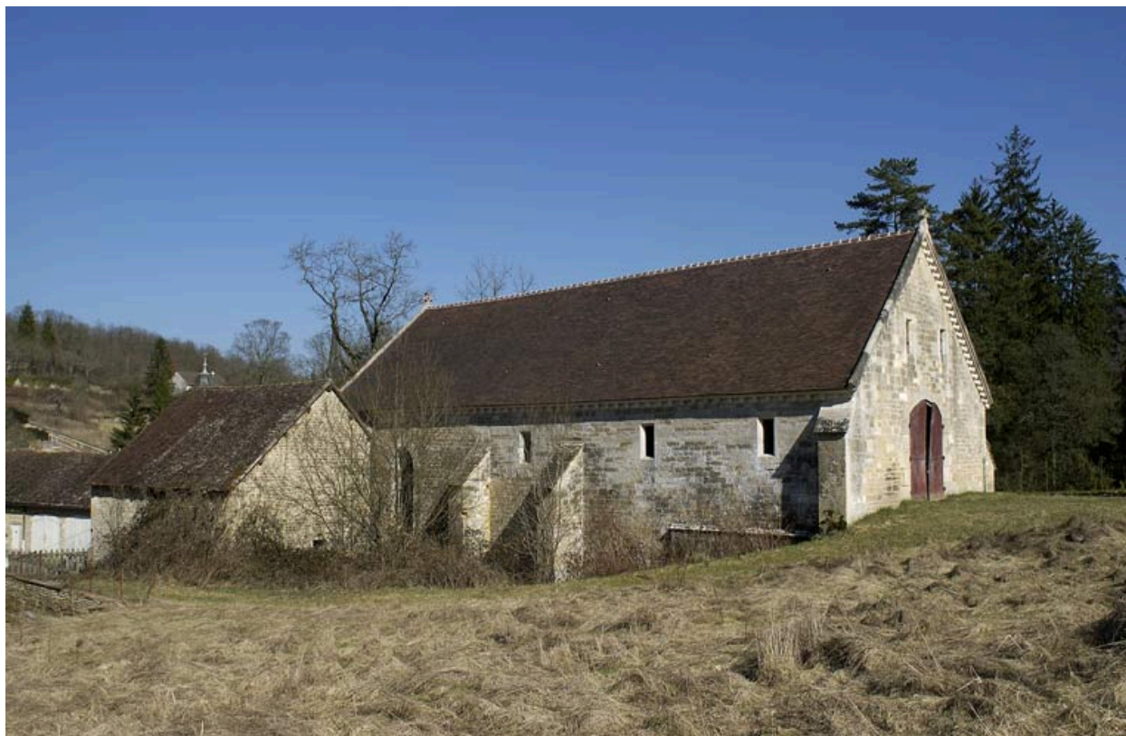
Cellier : élévation ouest.
