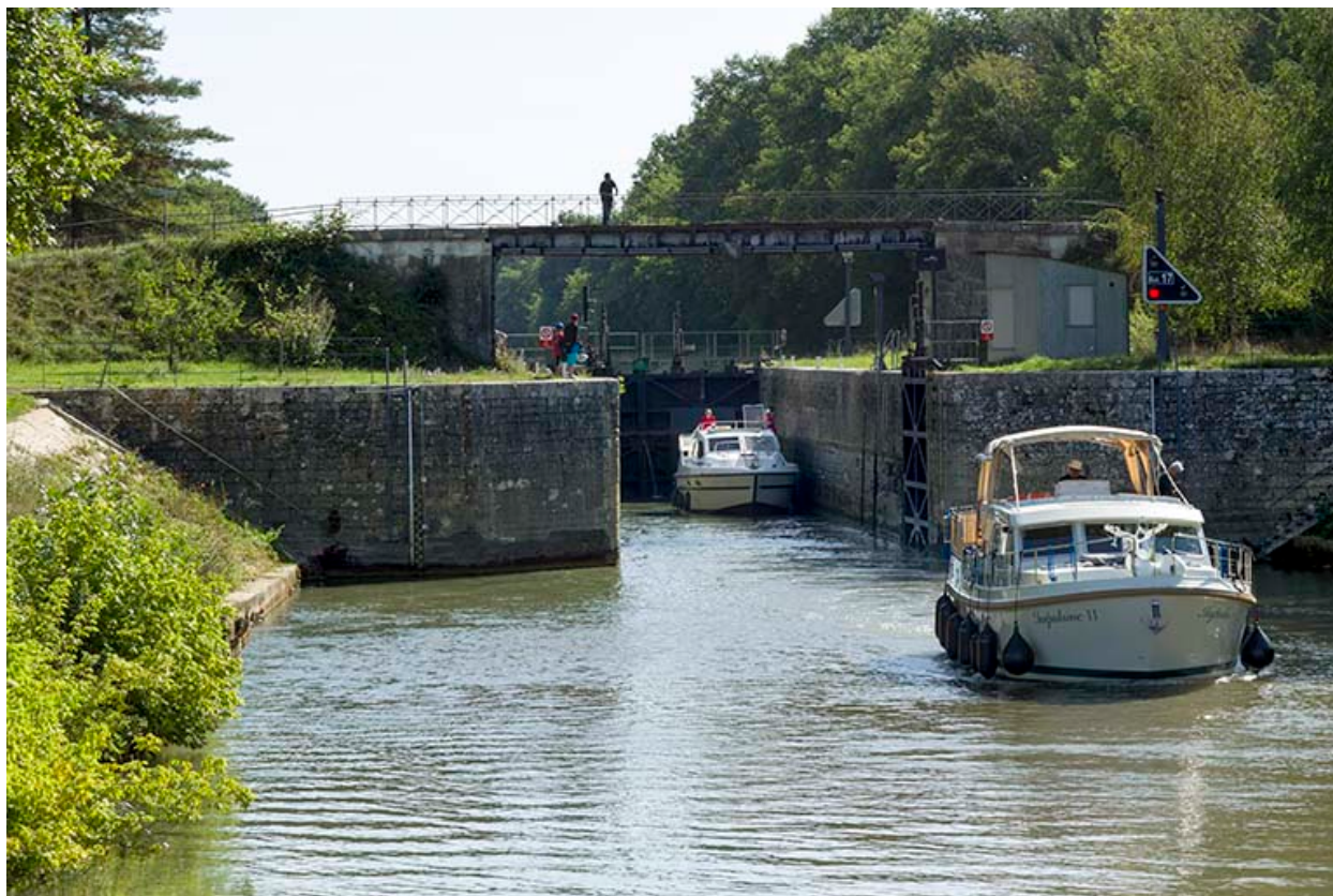
L'écluse depuis l'aval.
