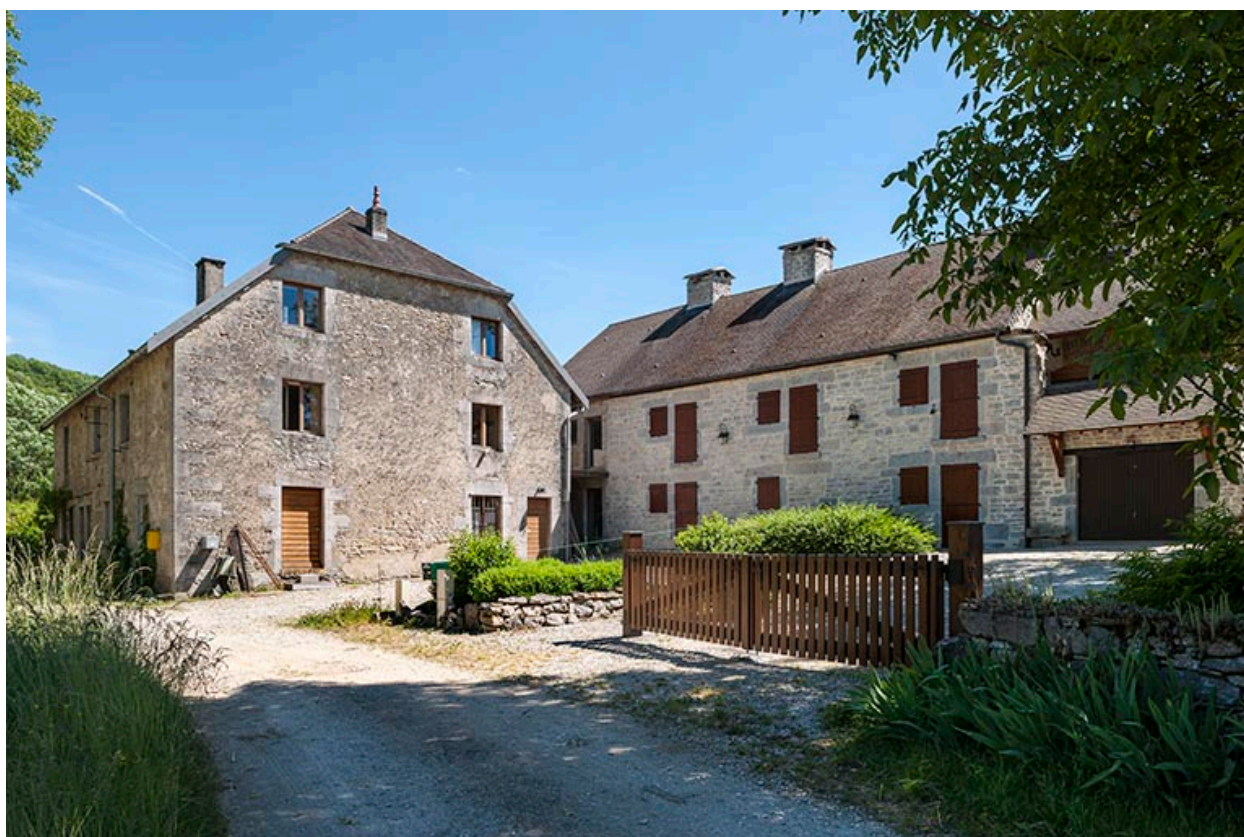
Logements d'ouvriers. Vue d'ensemble depuis le nord-ouest.
