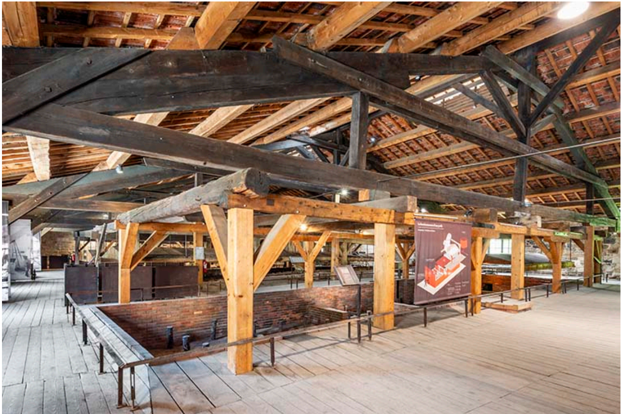
Vue d'ensemble de la salle des poêles depuis le nord-est.
